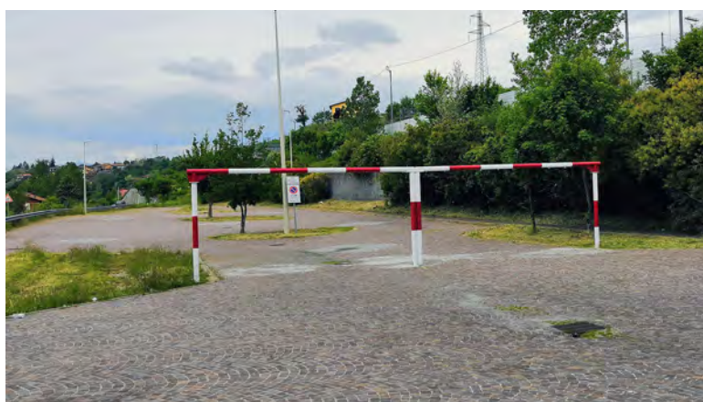
La sbarra installata per impedire l'accesso ai mezzi pesanti e ai caravan
