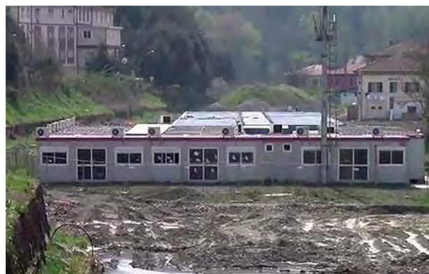
come eravamo: i container delle vecchie scuole elementari
