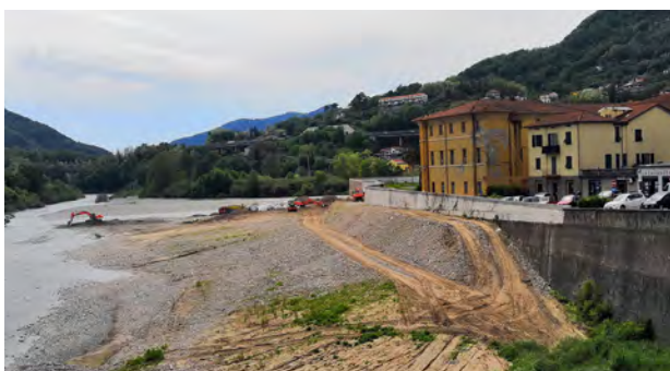
Lavori argine sul torrente Aullella
