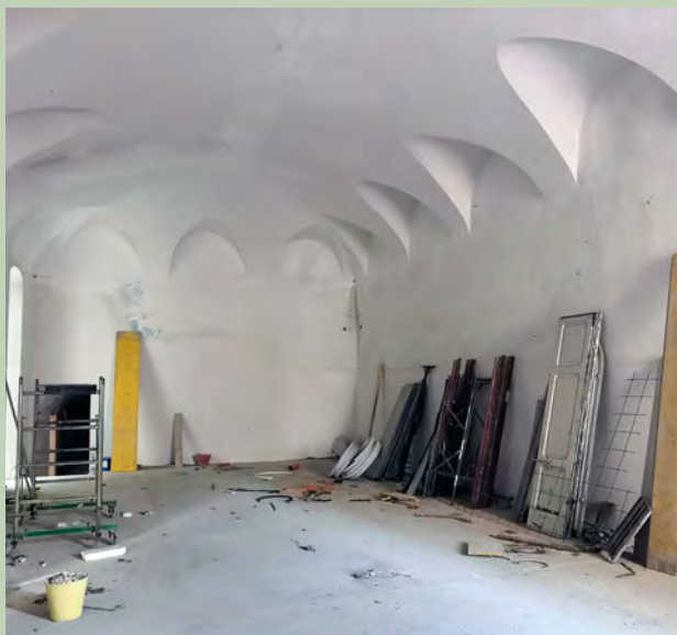
I lavori per la creazione del piccolo teatro delle muse
